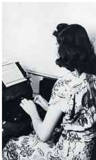
Fernschreiber dienten lange Zeit der drahtgebundenen Textübertragung.
